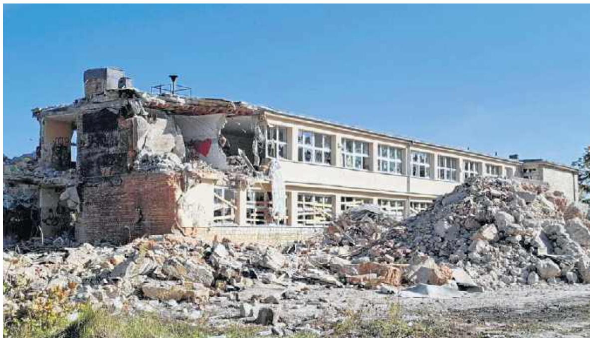
Dawna szkoła przy ulicy Kieleckiej w Starachowicach jest już rozbierana.
