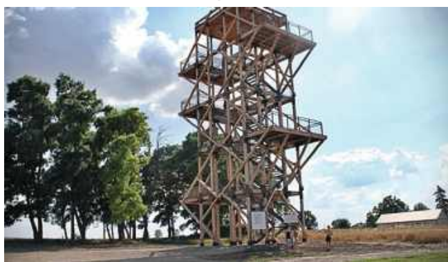
Wieża widokowa w Chłopiatynie będzie czasowo niedostępna dla zwiedzających. Fot. UG Dołhobyczów.
