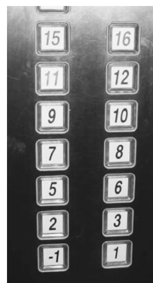
Panel windy w budynku mieszkalnym w Szanghaju. Brakuje pięter 4, 13 i 14 ze względu na podobieństwo wymowy słów „cztery” i „śmierć” w języku chińskim
