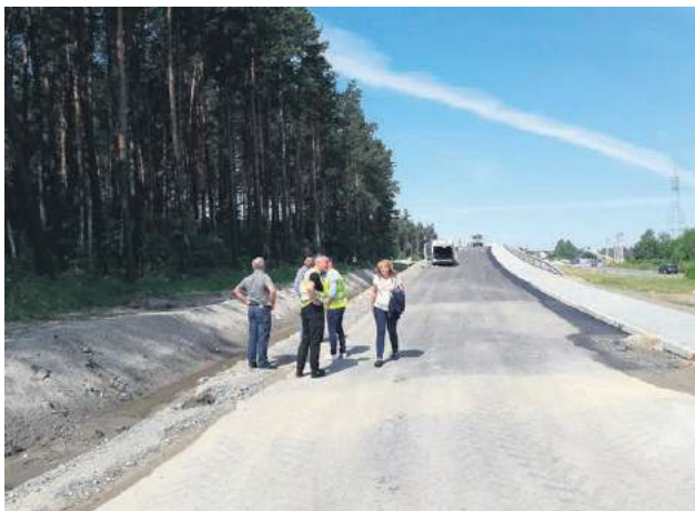
W związku z pracami przy budowie drogi S17 rowy zostały przysypane. To powoduje problemy.
