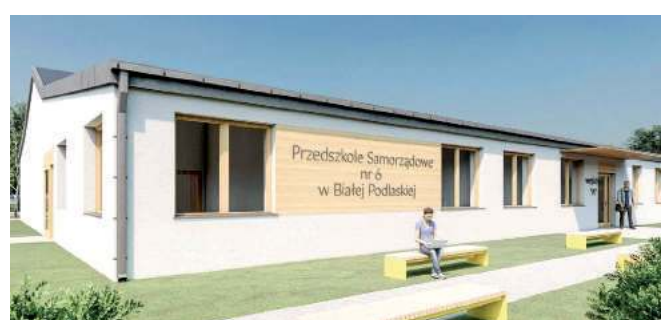
Placówka będzie mogła pomieścić 125 przedszkolaków, zostanie zagospodarowany teren wokół budynku
