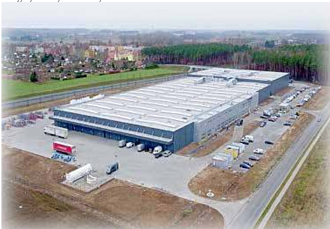
Do tej pory jedynym zakładem produkcyjnym w strefie była firma Press Glass
