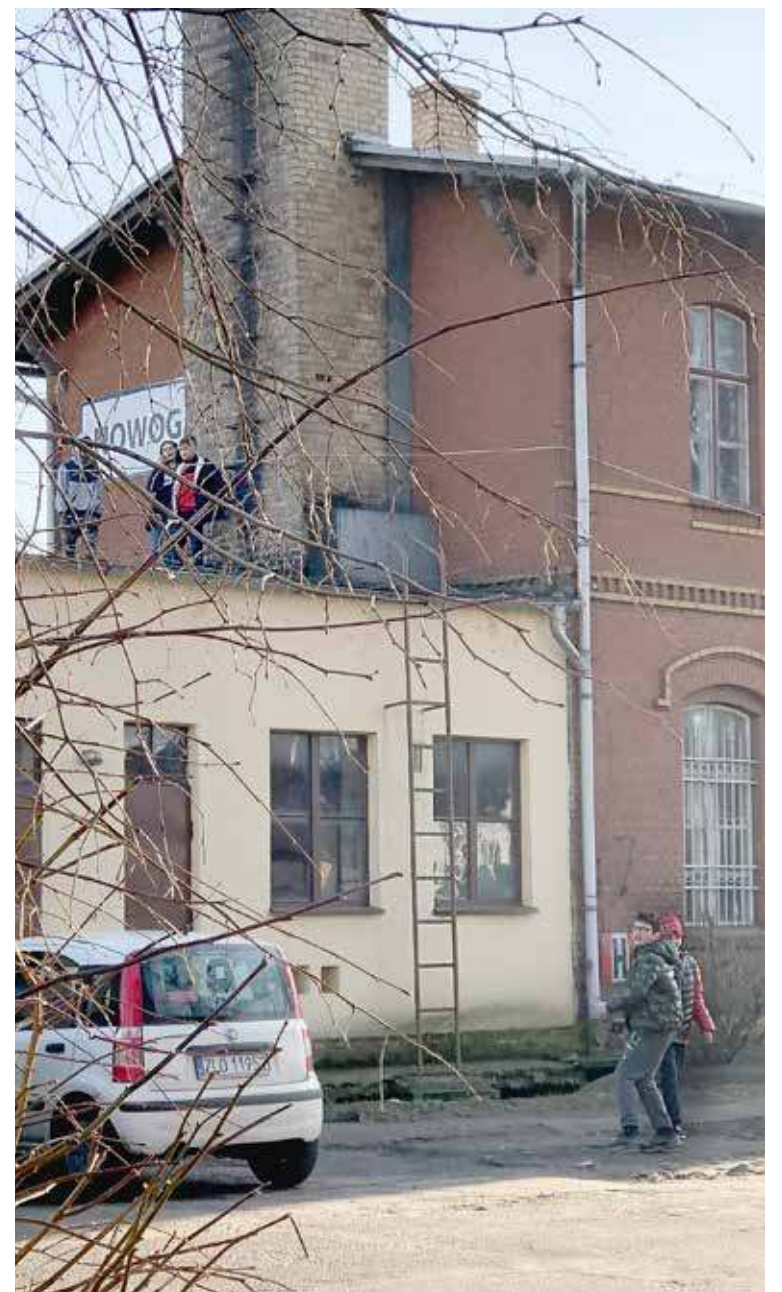
Na dach nowogardzkiego dworca można dostać się po widocznej drabinie
