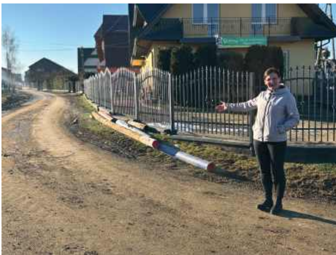
Richtárka ukazuje ako pokračujú práce v Krempachoch
