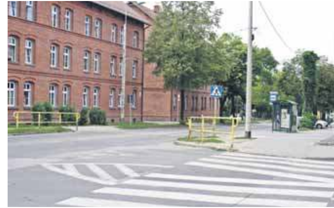
Prace obejmą m.in. stworzenie zatoczek dla przystanków autobusowych oraz przebudowę niebezpiecznego przejścia dla pieszych
