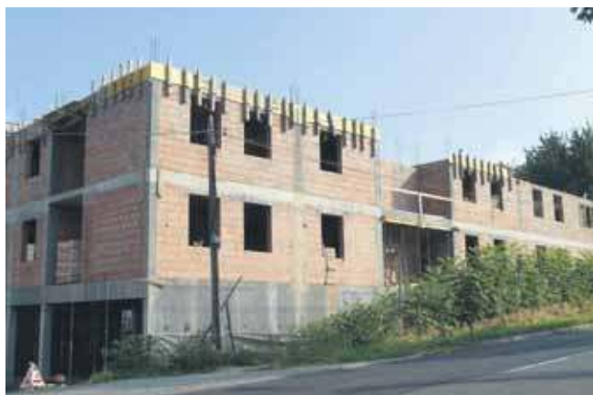
Budowa budynku mieszkalnego wielorodzinnego przy ul. Wyszńskiego
