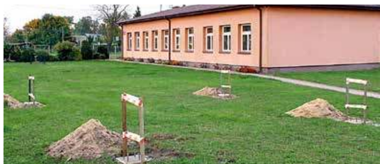
Turze Rogi. Na betonowych fundamentach już można instalować urządzenia do ćwiczeń.
