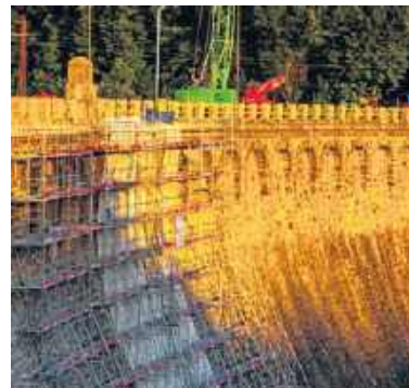
Trwa remont zapory
