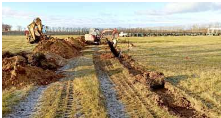
Na Nowym Cmentarzu rozpoczęła się budowa nowej alejki
