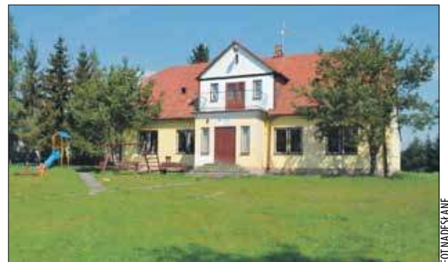
Szkoła podstawowa w Strzałkach od lat niszczeje, dlatego pozyskane z programu pieniądze zostaną przeznaczone na jej gruntowny remont i nadanie mu nowych funkcji
