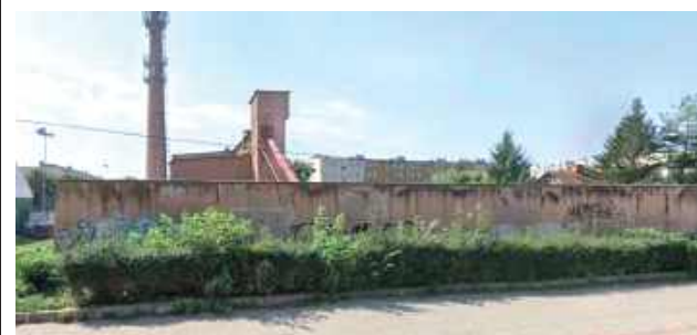
Prace rozbiórkowe potrwać do końca lipca br.
