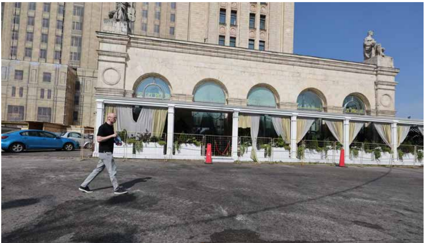
Restauracja „Balzi Rossi”, w której przeprowadzono zamach na gen. Aleksandra Czajkę, mieści się w Domu na Placu Kudryńskim, socrealistycznym wieżowcu zaliczanym do tzw. Siedmiu Sióstr w Moskwie Fot. media społecznościowe, domena publiczna
