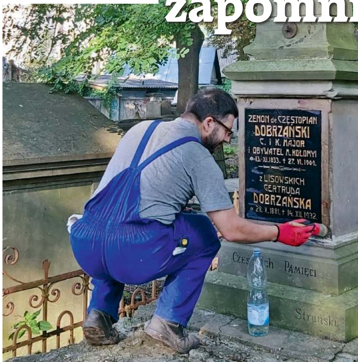
Prace na cmentarzu w Kołomyi w 2020 r. | fot. TMKK/d
