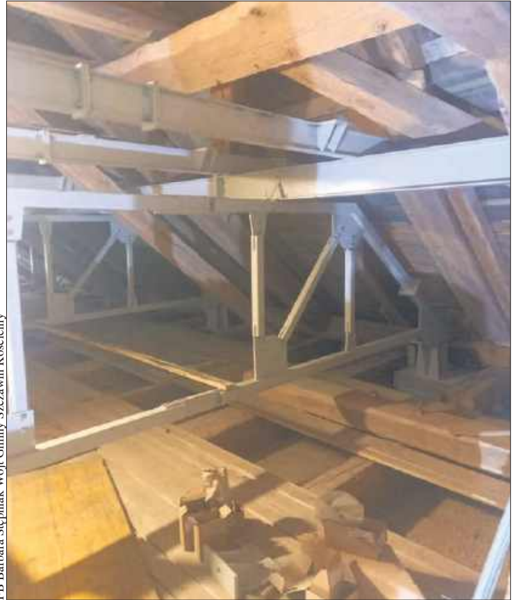
Remont w kościele w Suserzu
