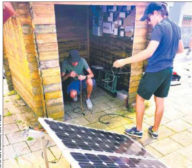
Elektrycy podczas budowy domu solarnego w Sewilli
