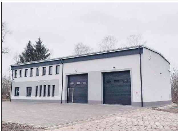
GZUK będzie prowadził zadania gminy między innymi z zakresu zarządzania siecią wodno-kanalizacyjną. Siedziba będzie się mieścić w wyremontowanym budynku przy ul. Rolniczej
