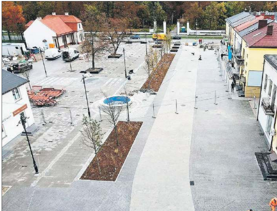
Przypomnieć warto, że w ubiegłym roku, gdy na pl. Rynek rozpoczęły się prace rewitalizacyjne, mieszkańcy otrzymali możliwość bezpłatnego parkowania na placu przygotowanym właśnie dla aut przy Grobli Kasztanowej i ul. Parkowej za pałacem Potockich
