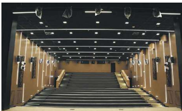
W sali widowiskowej m.in. odnowiono sufit i zamontowano oświetlenie ledowe
