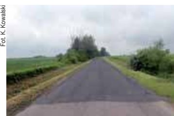
Nowo położona nakładka asfaltowa zakryła największe dziury
