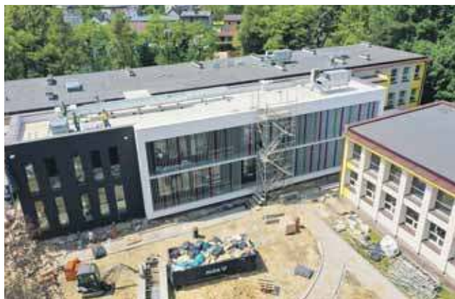
Dobudowana część jest już z zewnątrz gotowa, prace przeniosły się do środka
