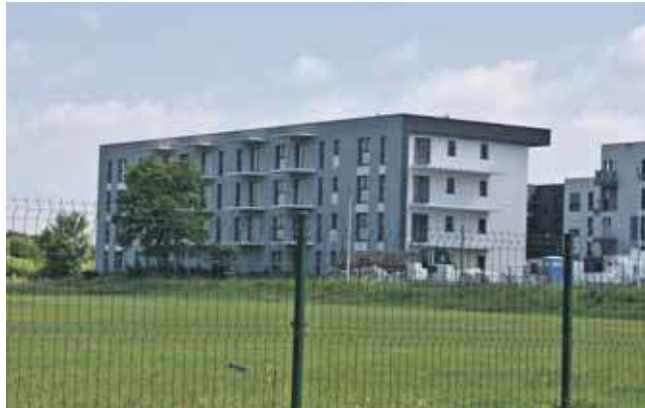
Najbardziej zaawansowane prace są w 4-kondygnacyjnym budynku
