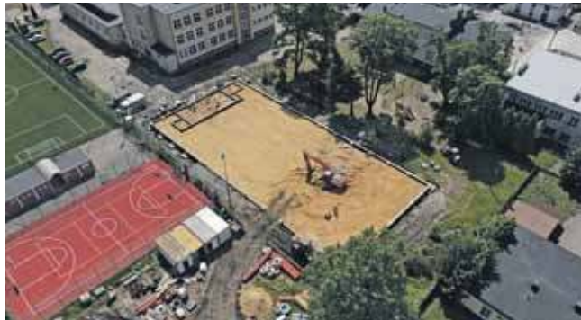
Hala będzie uzupełnieniem dwóch boisk, które wybudowano przy szkole podstawowej w Kaletach
