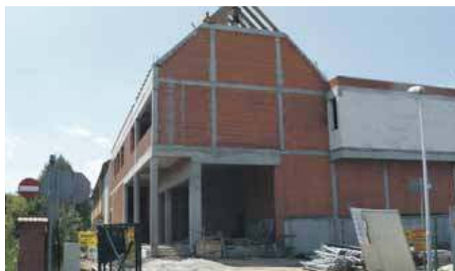
Wykonawca chce skończyć prace przed terminem
