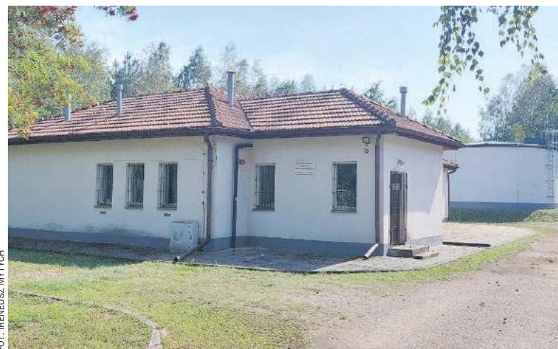
Stacja uzdatniania wody w Chwałowicach
