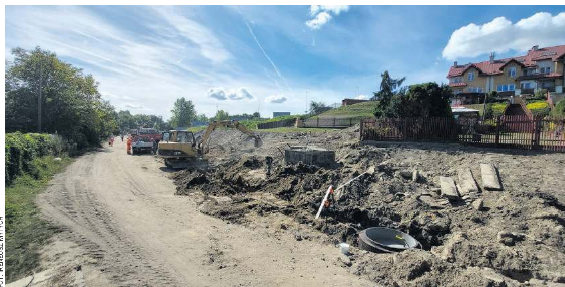
Modernizacji poddawany jest ponad 1,5-kilometrowy odcinek drogi
