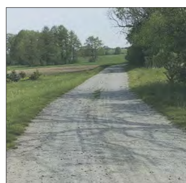
Droga przed przebudową
