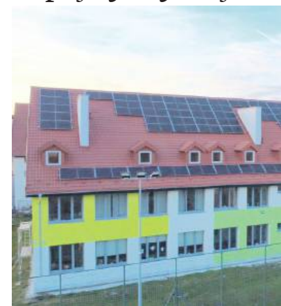
Termomodernizacja obiektów s
