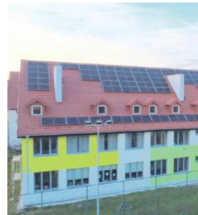
Termomodernizacja obiektów s
