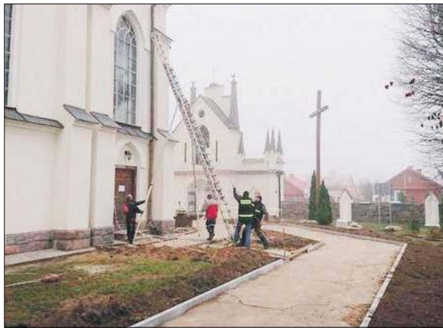
Ponad 100-letni kościół pw. Niepokalanego Poczęcia NMP w Starej Kornicy przeszedł gruntowny remont w 2017 roku
