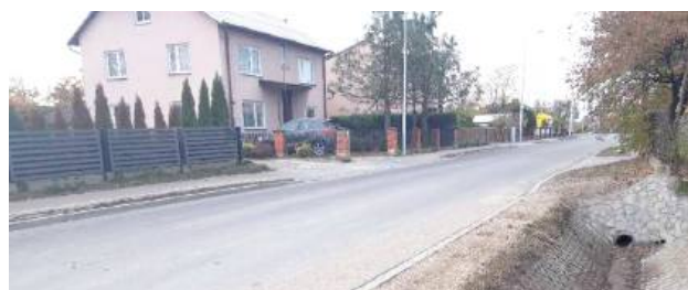
Długość przebudowanego odcinka drogi to 356 m
