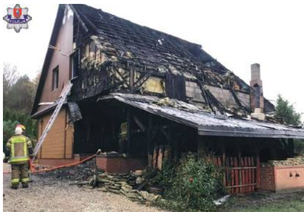
Pożar drewnianego domu w gminie Adamów. Ogień zauważyła właścicielka
