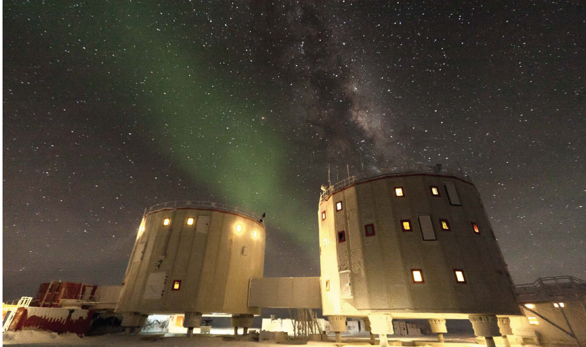
Stacja polarna Concordia składa się głównie z dwóch budynków (wież) obserwacyjnych o średnicy 18,5 m i wysokości 12 m oraz masie 200 t.
