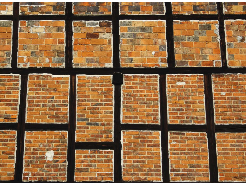
Sposób budowy muru pruskiego – belki i cegły
