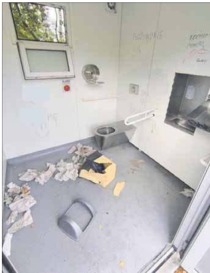
Zdewastowana toaleta w parku Podłężę (fot. MCKiS)
