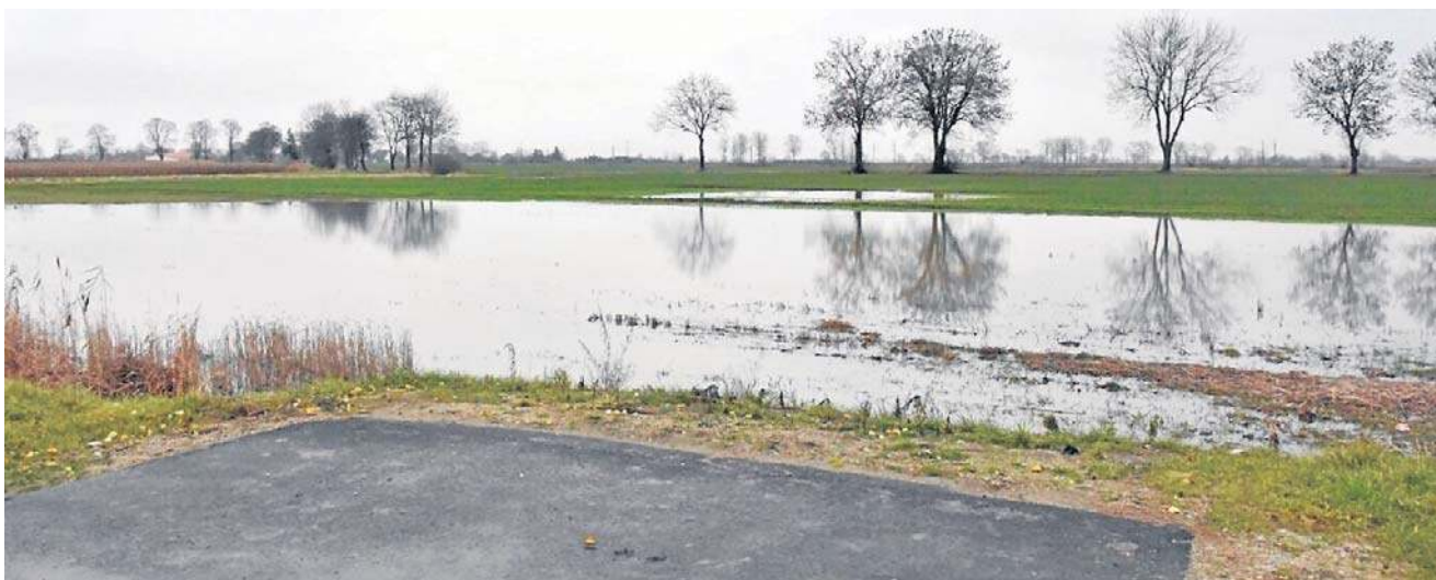
W Starym Polu woda zalewa teren leżący wzdłuż przebudowanej drogi
