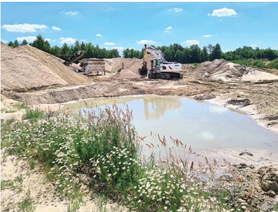
Przed ponad rokiem na budowie stawów były maszyny do przesiewania kruszywa
