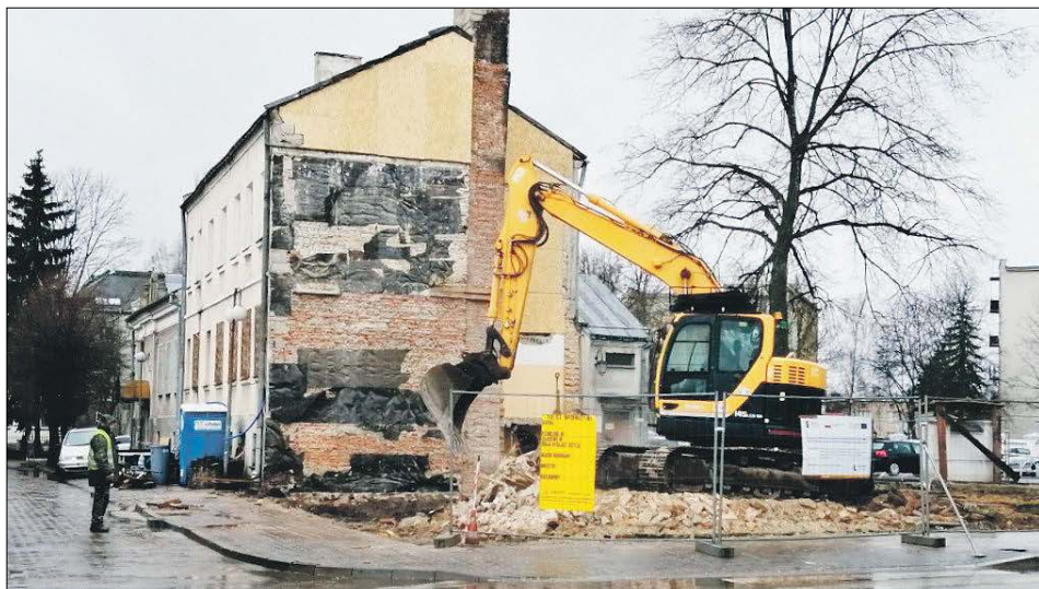
23 lutego Urząd Marszałkowski w Lublinie wszczął kontrolę doraźną, dotyczącą zamówienia publicznego na prace, związane z rozbiórką i budową budynku przy ul. Krótkiej
