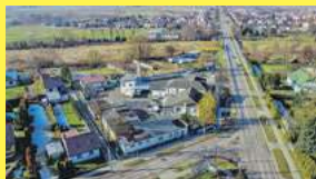
Nieruchomość przemysłowa w Międzyrzeczu Podlaskim z istniejącą hurtownią spożywczą i stacją gazu LPG. Przy ulicy Warszawskiej, blisko wyłotu na drogę E 30 (krajowa A2)
