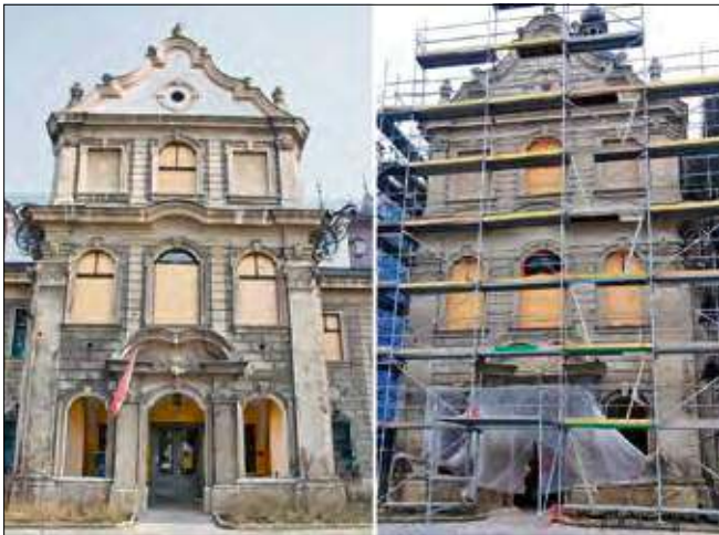
Elewacja czyszczona jest techniką piaskowania na sucho.
