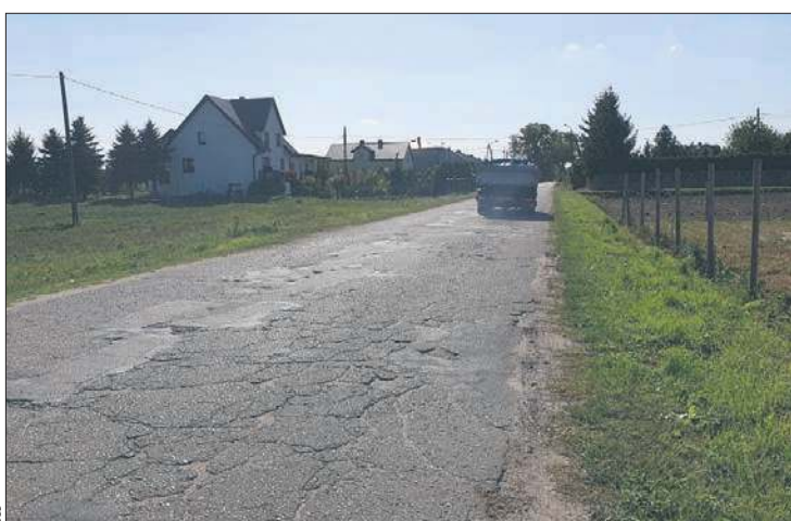
Już niebawem na trasie Radzanowo-Dębniaki - Chelstowo pojawi się nowa nawierzchnia
