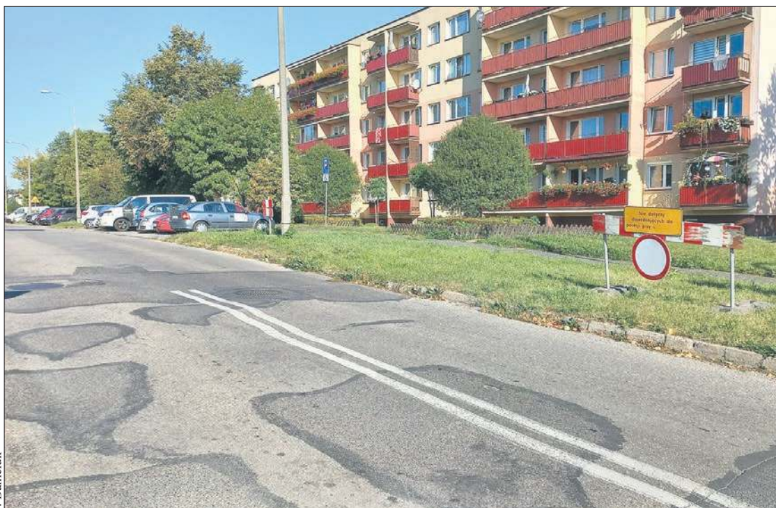
Przebudowa fragmentu ulicy Lasockiego potrwa 5 miesięcy
