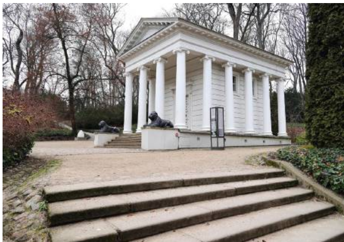
Świątynia Sybilli w Łazienkach Królewskich to symbol prestiżowego, ale niepotrzebnego budownictwa.
