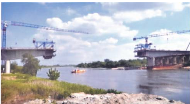
W taki sposób będzie budowany most na Odrze
