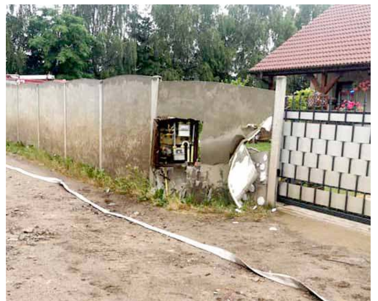
W miejscowości Niedźwiedź kierowca osobówki uderzył w skrzynkę gazową i doszło do rozszczelnienia instalacji gazowej. Na miejsce przybyli strażacy z OSP. Kobylanka
