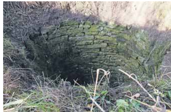
Szyb nr 16 sztolni Boże Wspomóż był głęboki kiedyś na ok. 17 m. Zasłepiono go i zasypano, ale materiał do tego użyty osunął się w nim i jego wewnętrzna górna część jest widoczna
