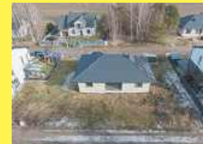
Dom z pompą ciepła i fotowoltaiką - Porosiuki, 604 494 489
