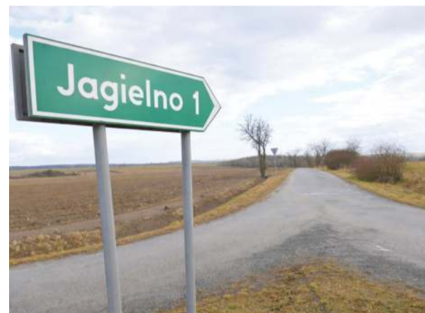
Droga do Jagielna jeszcze w tym roku zyska nową nawierzchnię
