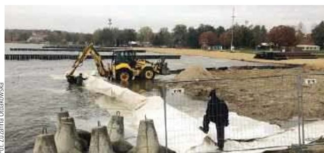
Prace przy molo trwają od początku września
