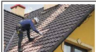
MALOWANIE DACHÓW. Tel. 504 043 310.
