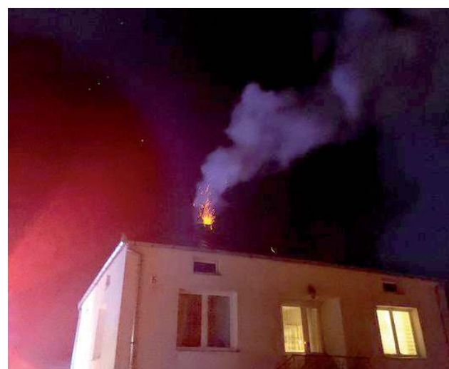
8 lutego, Zofiówka, pożar sadzy w kominie. Działania strażaków polegały na wygaszeniu pieca i palącej się sadzy proszkiem gaśniczym oraz wyczyszczeniu całego przewodu kominowego. W akcji udział wzięły JRG Łęczna i OSP Łęczna
