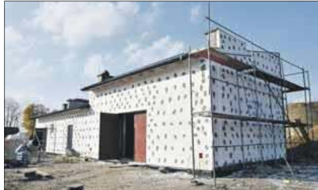
Modernizacja stacji uzdatniania wody w Rogoźnicy to koszt ponad 2 milionów złotych
