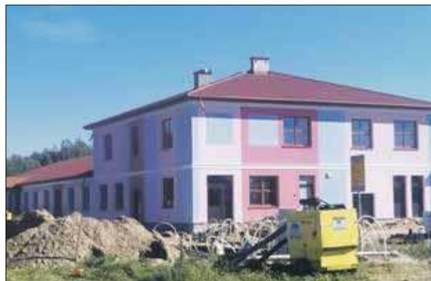
W Curyńie trwają intensywne prace remontowe. Rozpoczęcie funkcjonowania ZOL-u planowane jest na drugi kwartał 2021 r.
