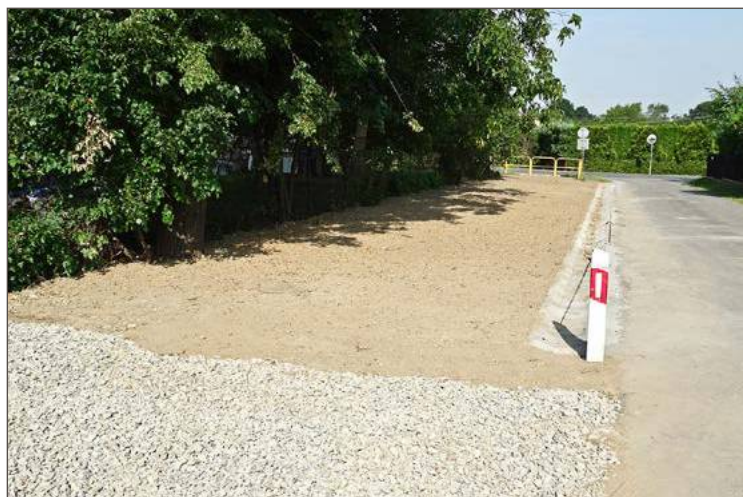
Rów został przykryty na długości 50 metrów.
