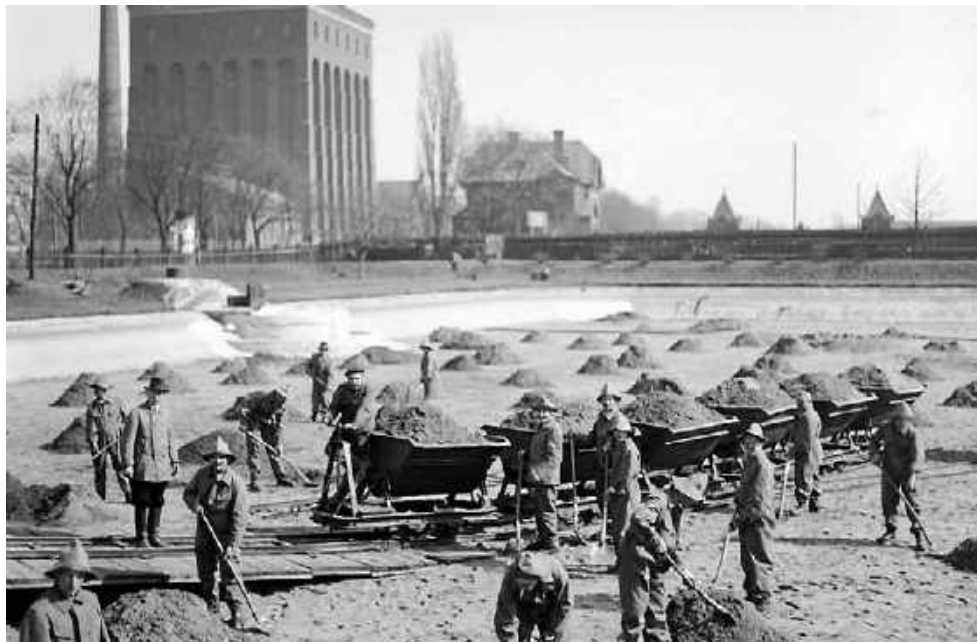
Wymiana złoża piaskowego w filtrze, zdjęcie z lat 20. XX wieku
