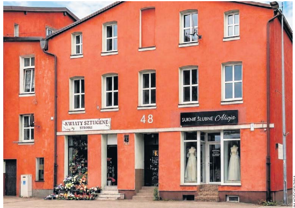
To następny etap modernizacji obiektu, rozpoczętej już w 2025 roku
