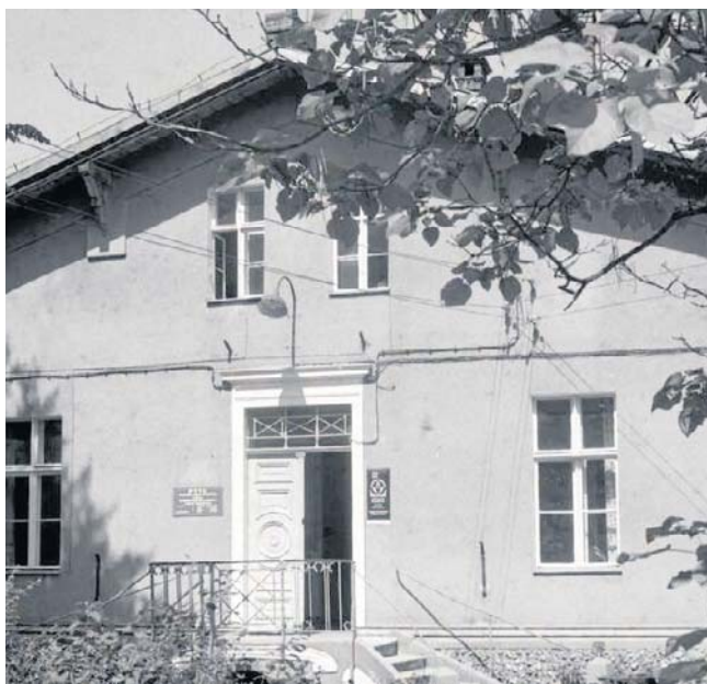
Dawna siedziba Zarządu Odbudowy Zamku. Rok 1983
