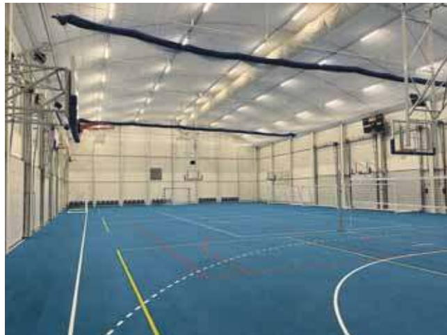
W Kaletach powstała hala z zadaszeniem łukowym o konstrukcji metalowej z powłoką membranową
