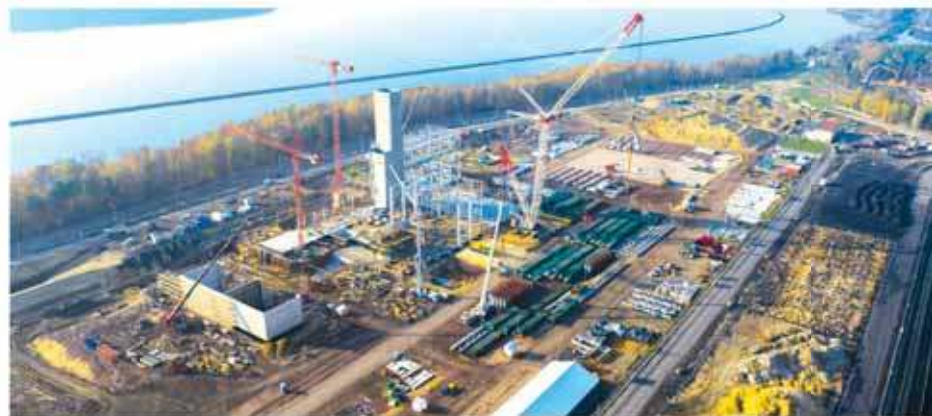
Nowo budowany blok gazowo-parowy w Rybniku
