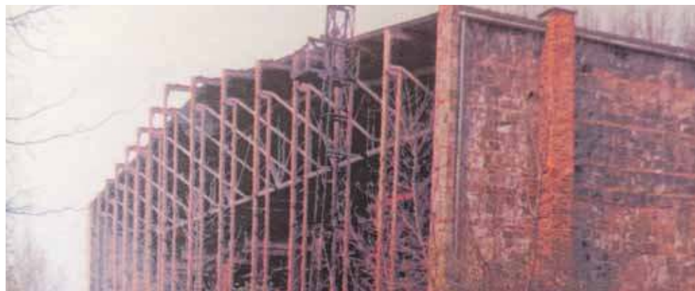
Hala, której budowę rozpoczęto w latach 70. XX wieku, przez wiele lat niszczała i straszyla
