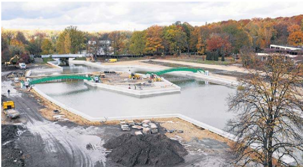
Park Śląski zamienił się w jeden wielki plac budowy. Tak z góry wygląda przebudowa Kanalu Regatowego
