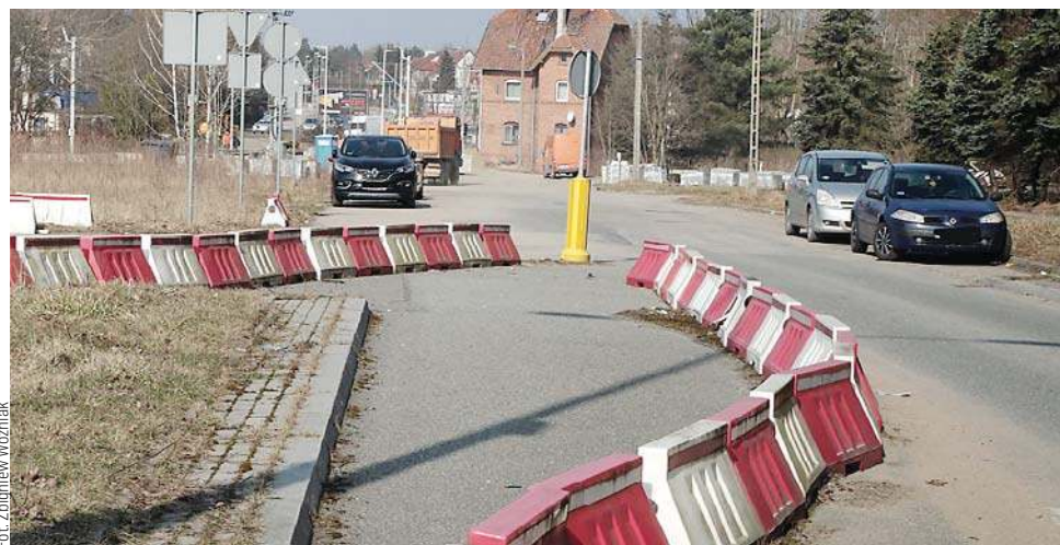
Budowa ul. Nowobałtyckiej to jedna z najważniejszych drogowych inwestycji w Olsztynie
