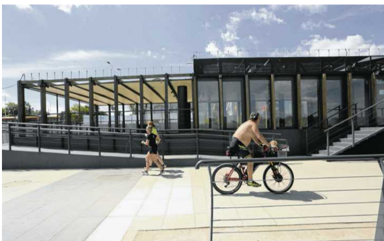
• Miasto zapowiada przetarg, ale najpierw konieczny jest remont części budynków FOT. ADAM STĘPIEŃ / AGENCJA WYBORCZA.PL
