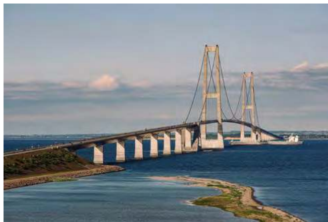
Storebæltsbroen – spinający wyspy Fionię z Zelandią (jego wschodnia część), rozciągnięty ponad wodami Wielkiego Beltu. Foto – Dreamstime
