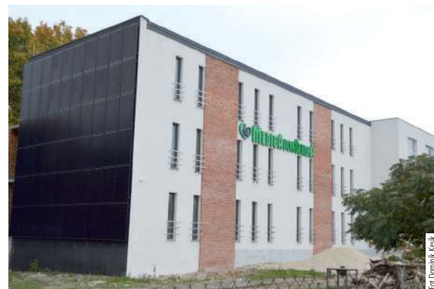
Prace nad Domem Seniora są już praktycznie na ukończeniu. Placówka ma zostać otwarta w 2023 r. (zdjęcie wykonano pod koniec września br.)
